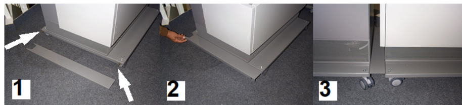
Abbildung 79: Befestigen der Erdlaschen an den Boxensockeln
