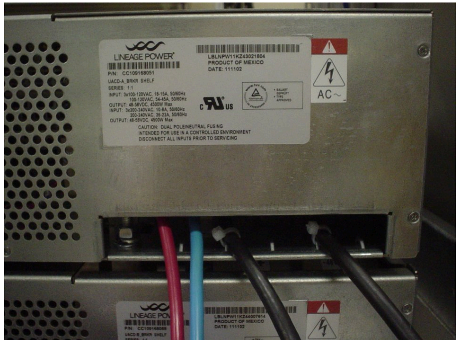
Abbildung 141: Batterie und -48-V-Ausgang
