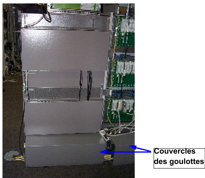
Figure 207: Placer les couvercles des goulottes de câbles
