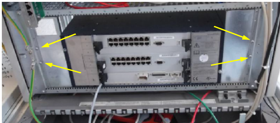
Figure 31: Dévissage de la fixation du CSPCI
