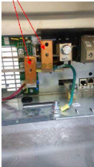
Barres de connexion C176 (2x)
