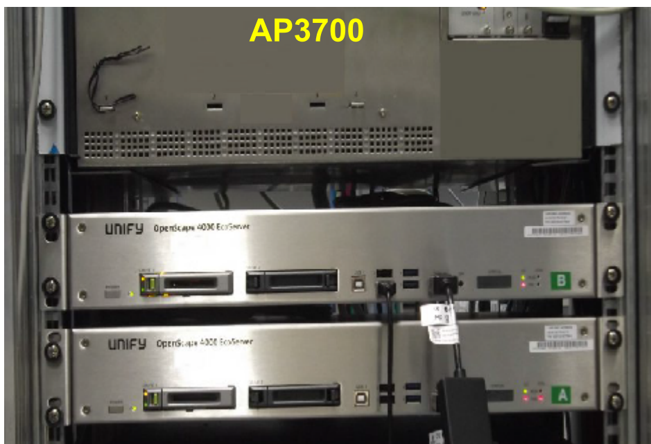
Figure 60: Exemple de structure 19" avec EcoServer (duplex) et AP3700
