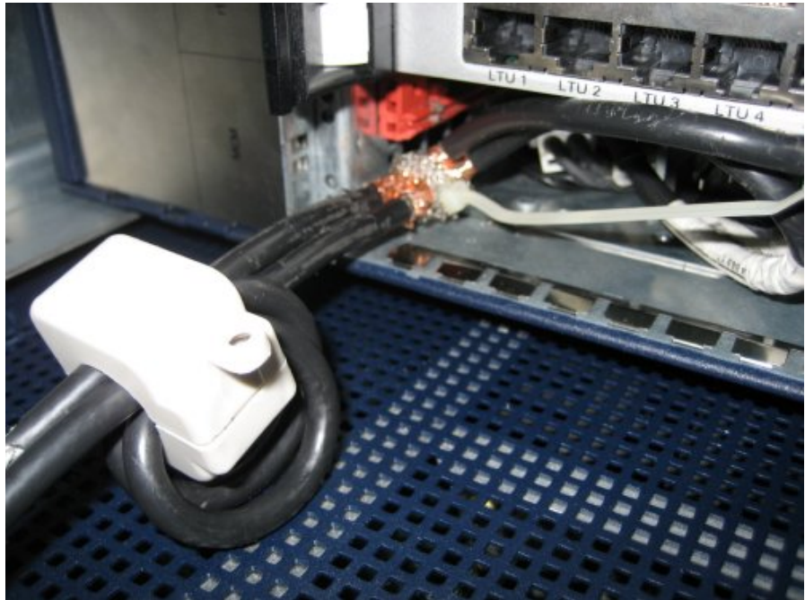
Figure 44: Tore de ferrite fermé avec câble de raccordement
