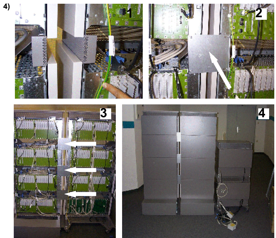
Figure 80: Pose des pattes de mise à la terre entre les différents boîtiers
