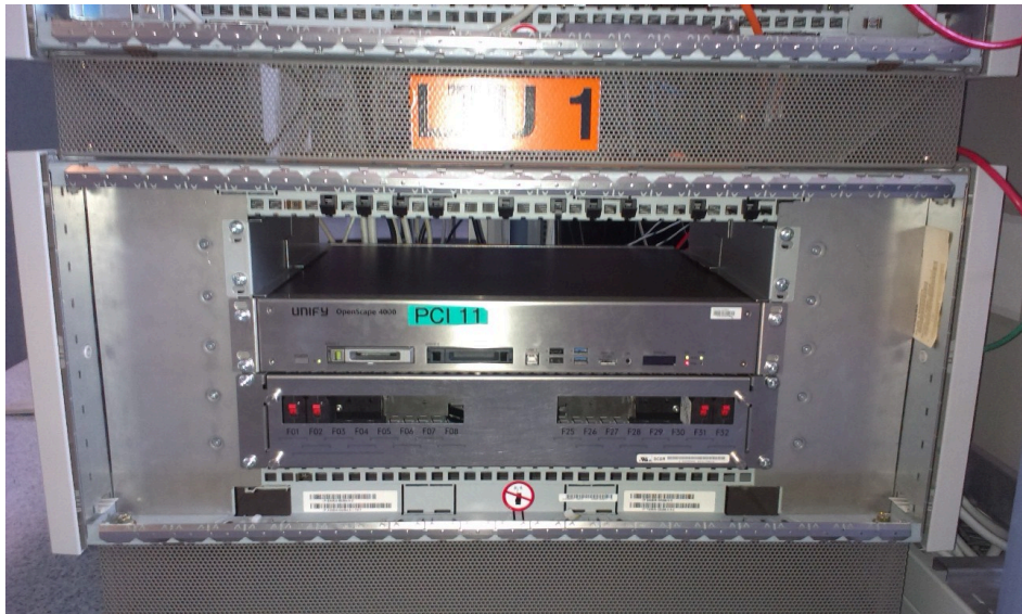
Figure 26: Raccordement CC EcoServer avec DCDR (kit CC pour armoire 30")
