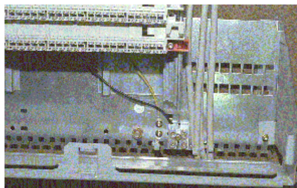
Figure 119: Raccordement du répartiteur principal -48 V
