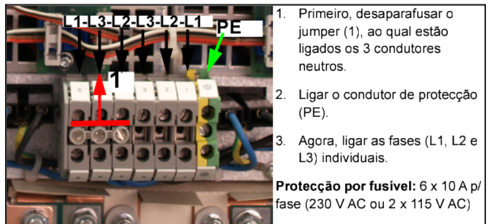
Figura 200: Ligação numa rede triangular (PSR930/PSR930E)
