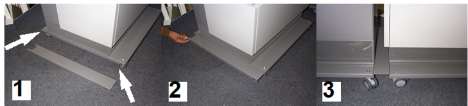
Abbildung 79: Befestigen der Erdlaschen an den Boxensockeln
