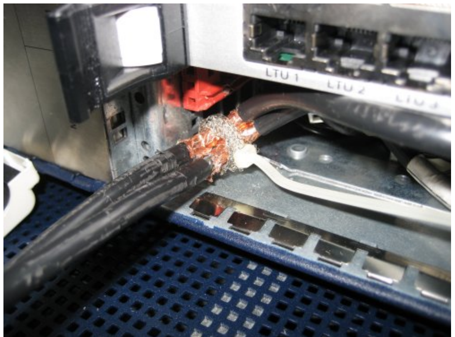
Abbildung 42: Schirmung der DC-Leitung an Gehäuse
