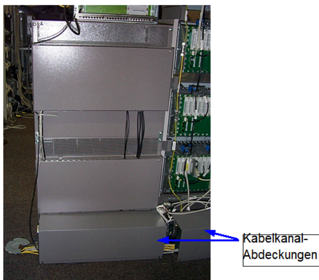
Abbildung 207: Kabelkanal-Abdeckungen anbringen
