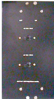
Abbildung 205: Ausgangsverteiler (ODP), Vorderansicht
