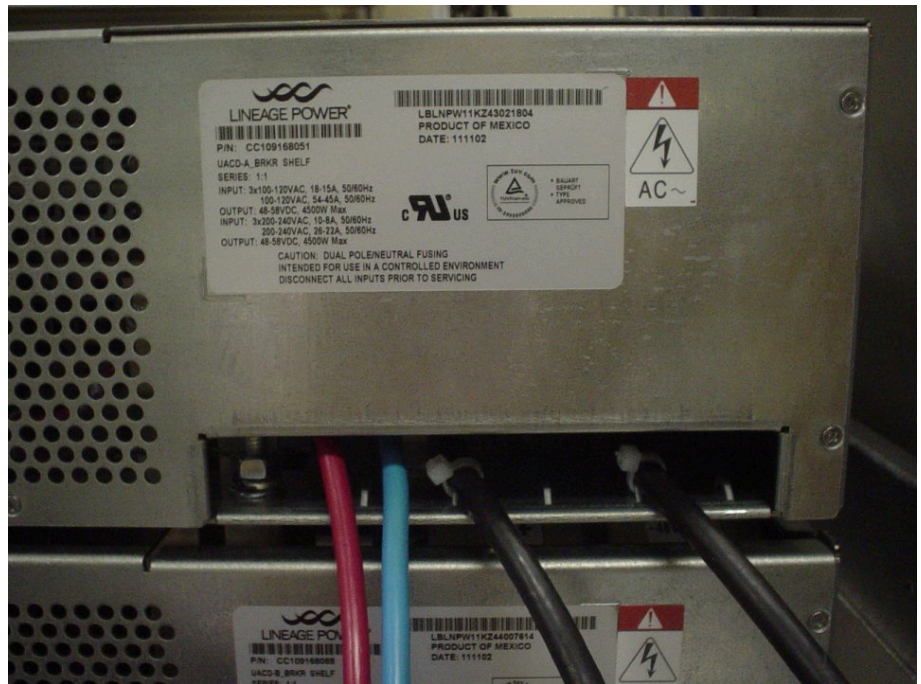
Abbildung 141: Batterie und -48-V-Ausgang
