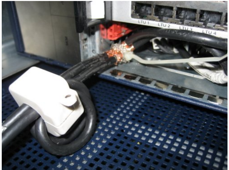
Abbildung 45: Geschlossener Ferritkern mit DC-Leitungen
