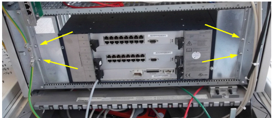
Abbildung 32: CSPCI-Befestigung entfernen
