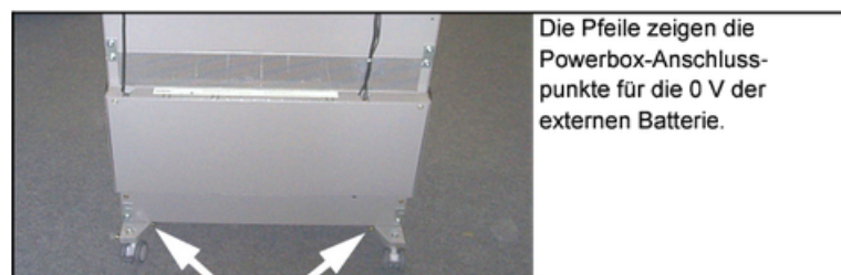
Abbildung 115: 0-V-Batterieanschluss
