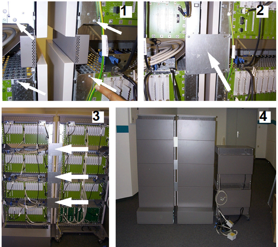
Abbildung 80: Anbringen der Erdlaschen zwischen den einzelnen Boxen
