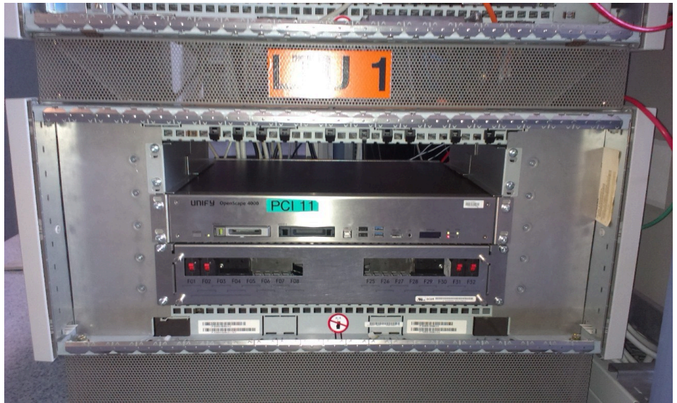
Abbildung 26: DC-Anschaltung EcoServer mit DCDR (DC-Kit für 30â€-Schränk)
