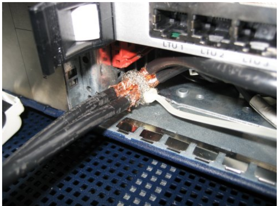
Figure 40: Blindaje del cable c.c. en la caja
