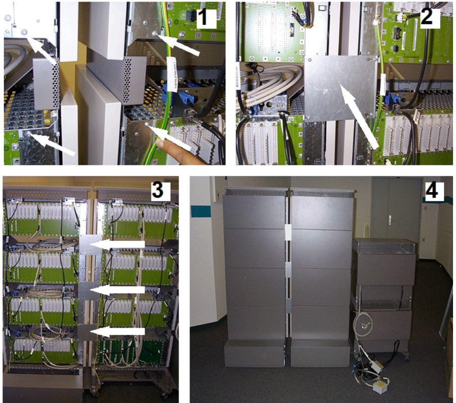
Figure 79: Colocación de las bridas de tierra entre los diferentes armarios
