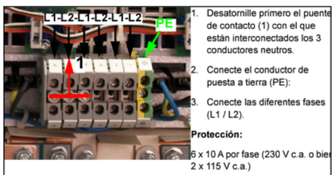
Figure 164: Conexión a una red bifásica (PSR930/PSR930E)
