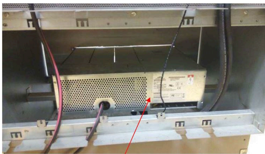
Cubierta metálica trasera de UACD A
