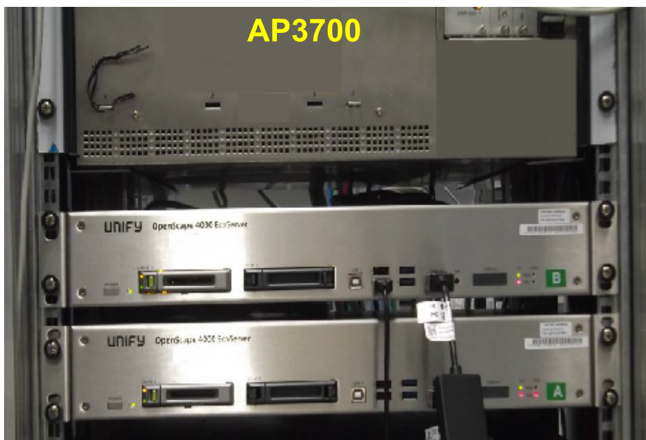
Figure 59: Ejemplo montaje de 19" con EcoServer (dúplex) y AP3700
