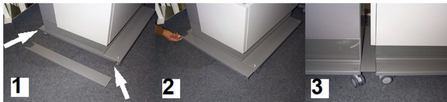
Figure 78: Sujete las bridas de tierra a los zócalos de los armarios
