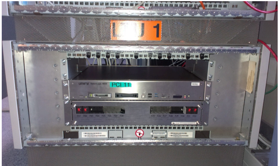
Figure 24: Conexión c.c. EcoServer con DCDR (kit cc. para armario 30")
