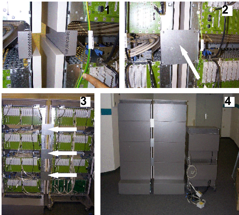
Figure 80: Pose des pattes de mise à la terre entre les différents boîtiers
