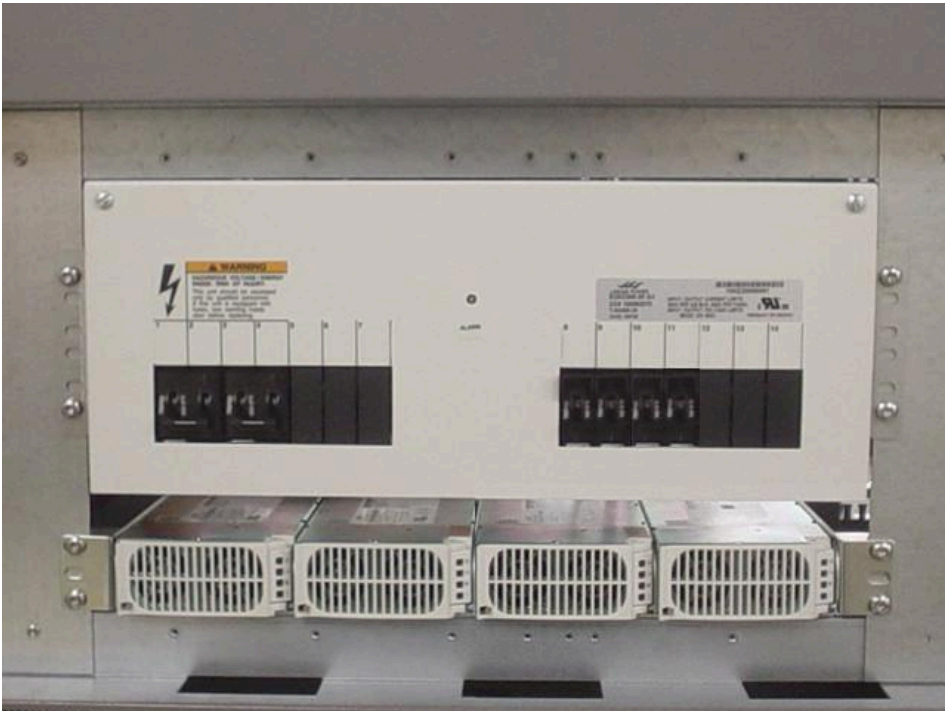
Figure 175: Boîtier d'alimentation Lineage Power (configuration complète)
