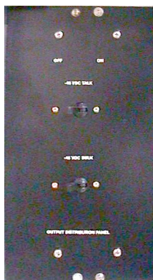
Figure 205: Répartiteur de sortie (ODP), vue avant
