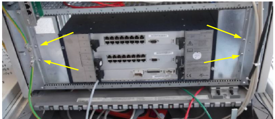
Figure 31: Dévissage de la fixation du CSPCI
