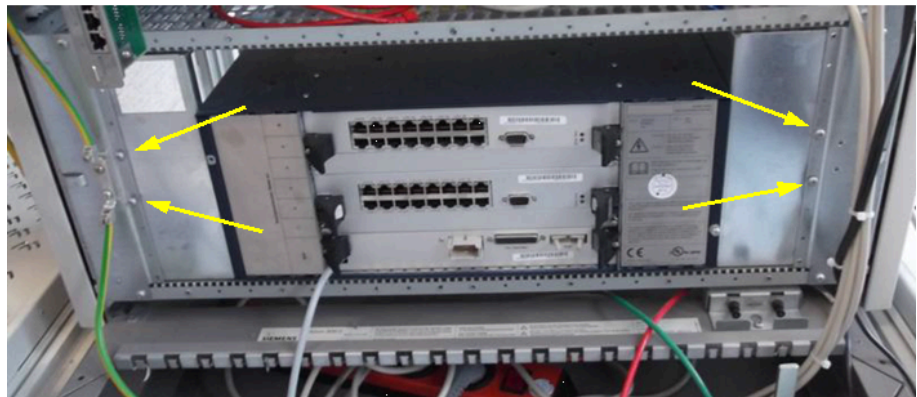
Figura 33: Remover a fixação CSPCI
