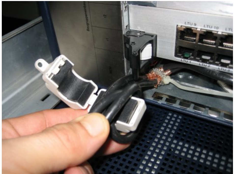
Figura 54: Laço dos cabos DC no núcleo de ferrite
