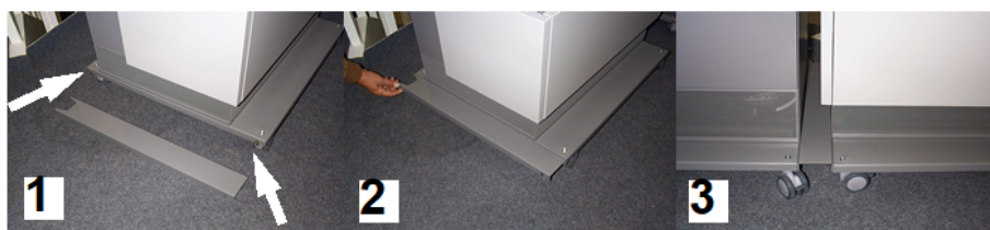
Figura 113: Fixação das juntas de terra nas bases das caixas
