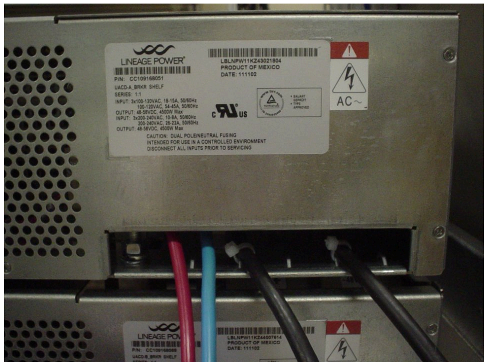
Figura 175: Bateria e Saída -48V
