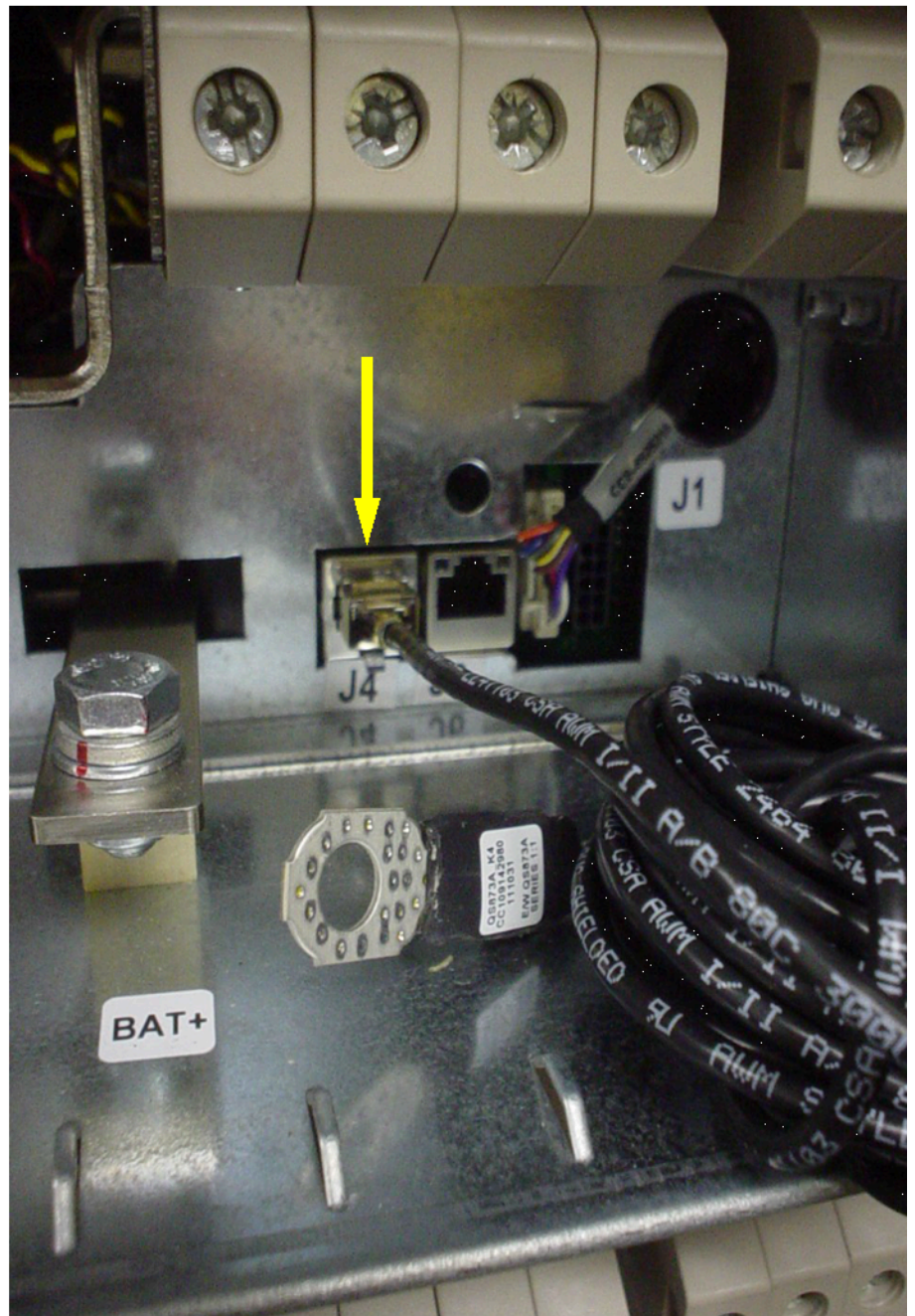
Figura 177: Ligação J4 da sonda térmica
