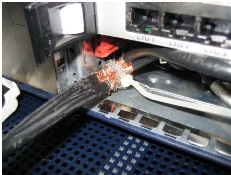
Figura 52: Blindagem do cabo DC na carcaça
