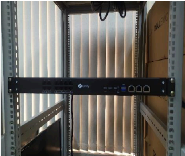
Figura 12: Ejemplo - Fijación de 19" (carril vertical)
