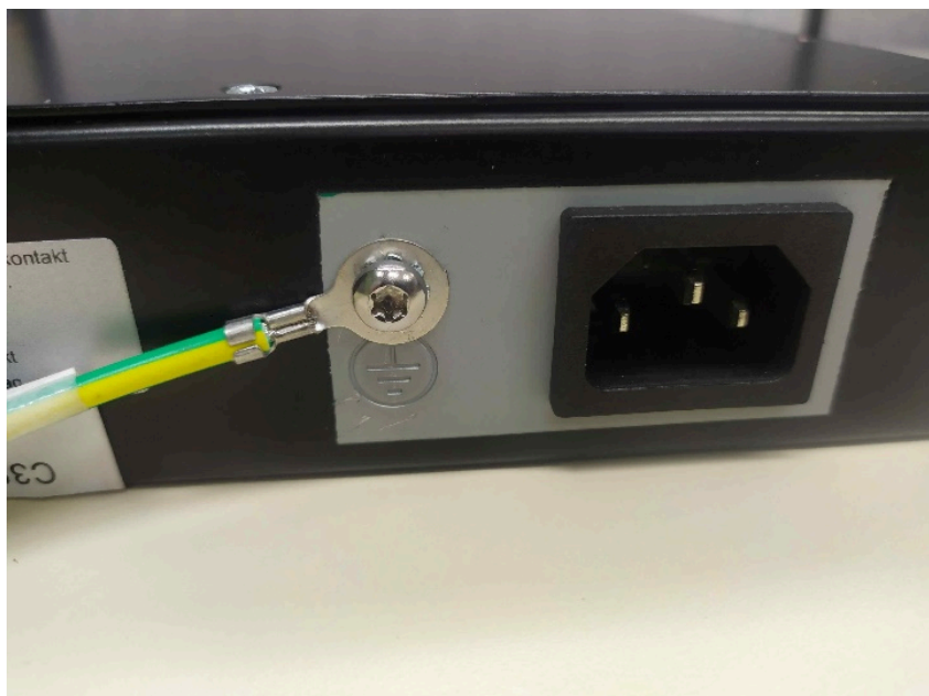
Figura 2: Montagem do terminal de proteção (terra)
