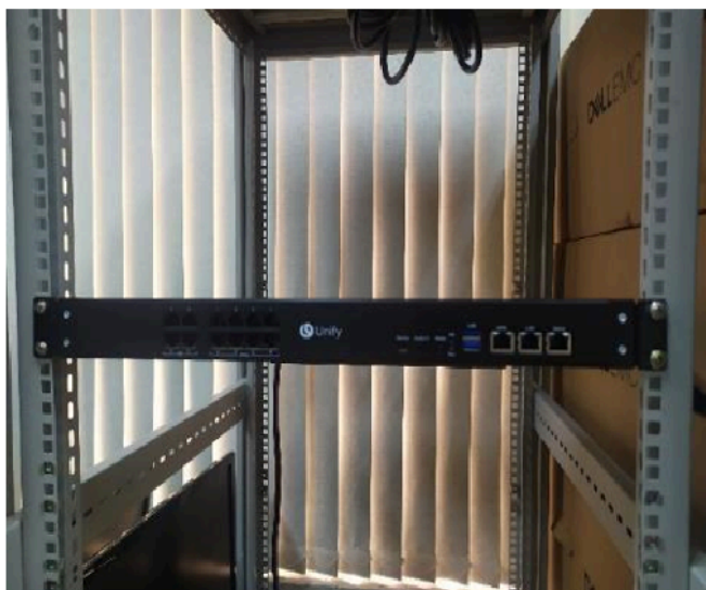
Figura 12: Exemplo - fixação de 19" (calha vertical)
