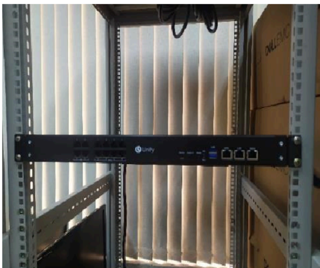
Figura 12: Esempio – Fissaggio 19" (binario verticale)
