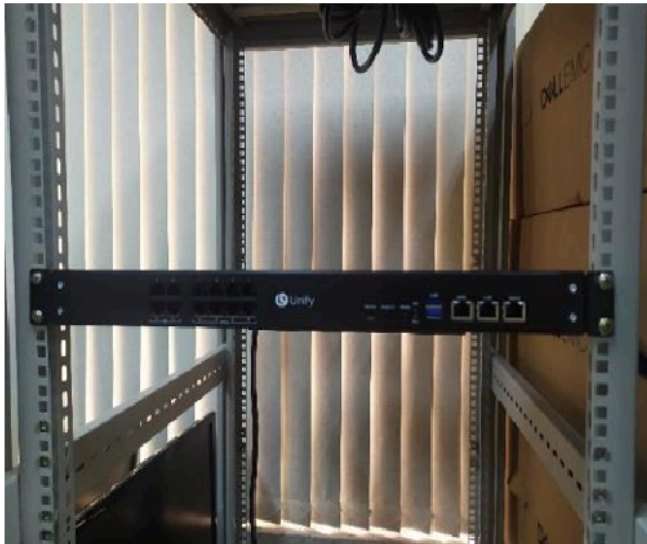
Figura 12: Exemplo - fixação de 19" (calha vertical)
