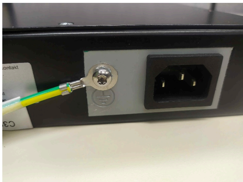
Figura 2: Montagem do terminal de proteção (terra)
